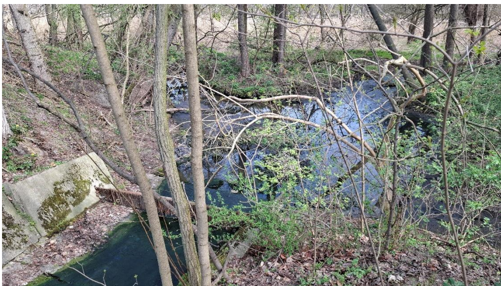
Obr. 26 Vyústění z ČOV
