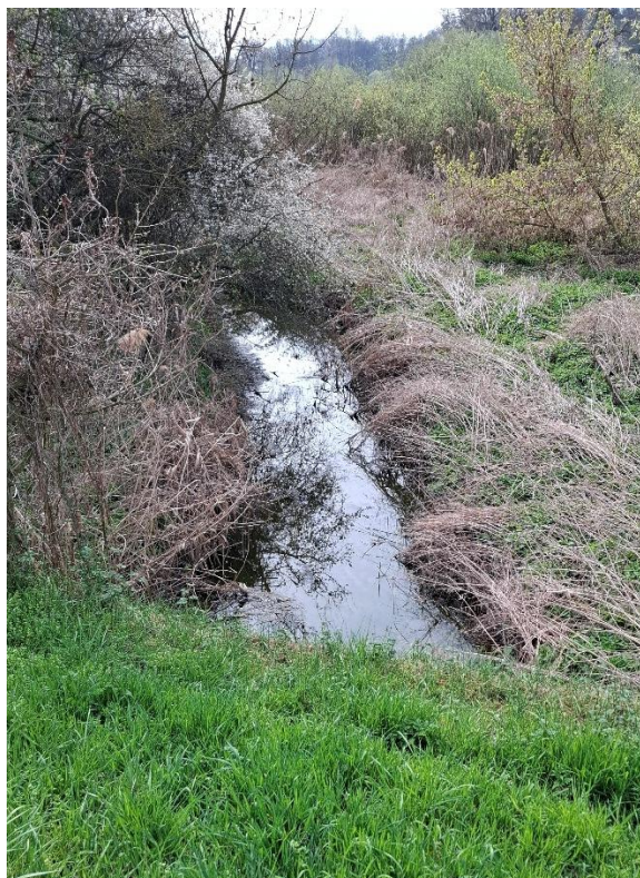
Obr. 25 Vyústění toku propustkem do Labe
