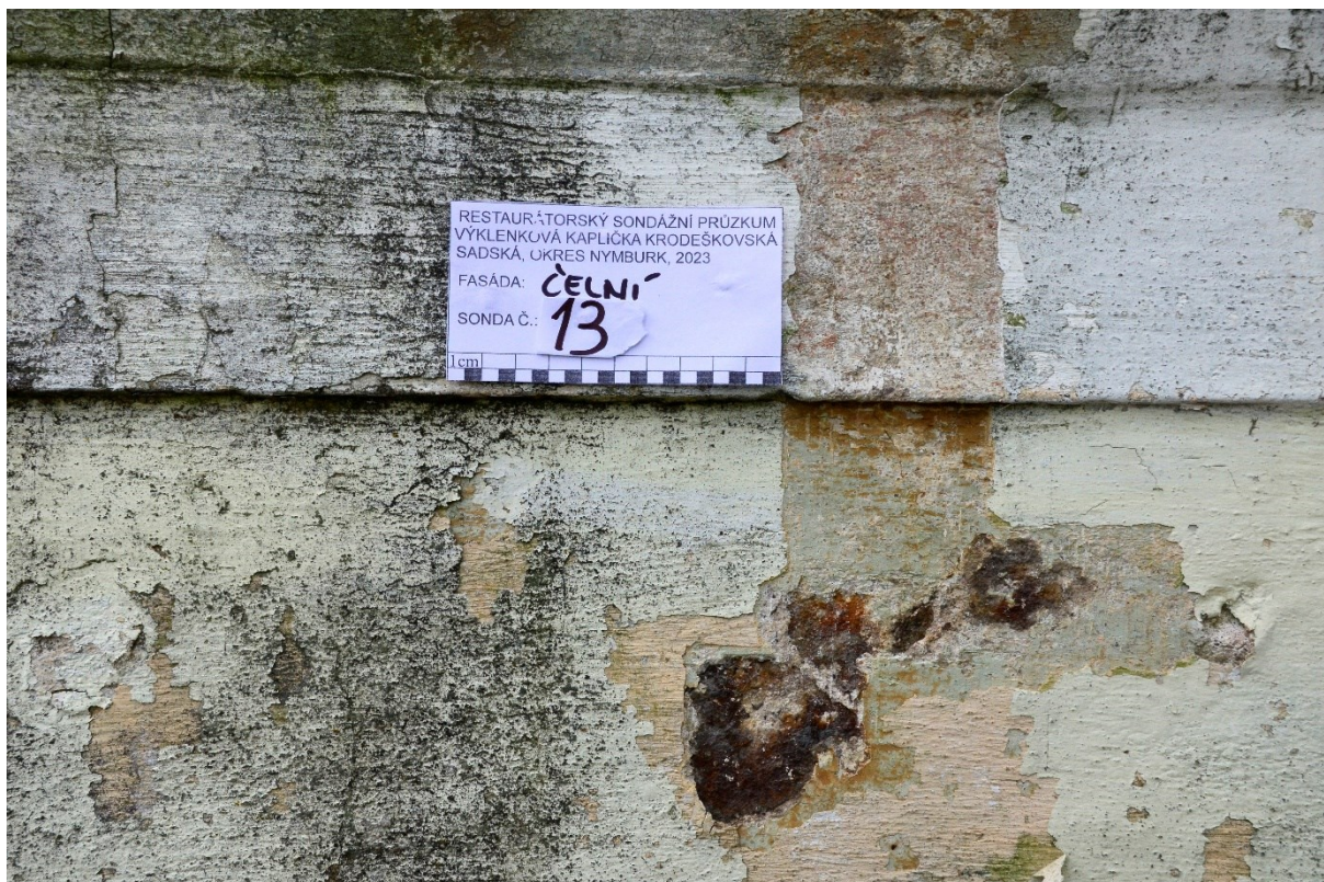
Obr. 22 Sonda č. 13, původní vrstvy ve špatném stavu, mladší vrstvy tvrdé, špatně odstranitelné.
