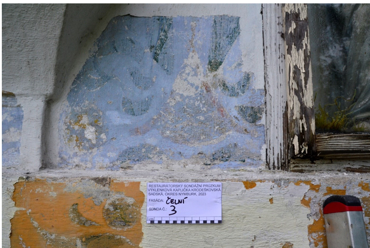
Obr. 5 Část sondy č. 3, vlevo od niky je pravděpodobně identické členění malířské výzdoby.
