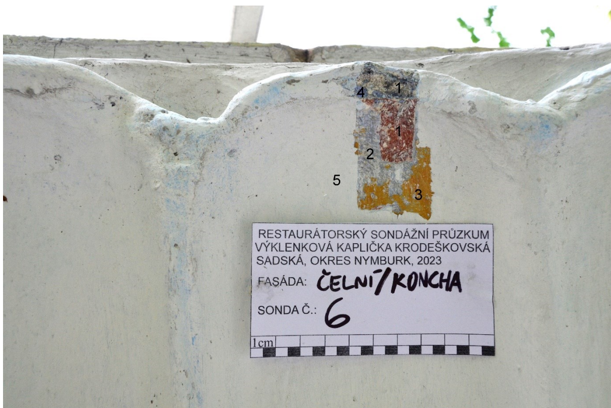
Obr. 12 Sonda č. 6, při horní hraně niky. Stratigrafie: 1 – červená, okraj černě odlišený, 2 – šedomodrá, nanášená v několika vrstvách, 3 – tmavý žlutý okr, 4 – tmavě modrá, 5 – bílá současná. V nise je dochováno větší množství barevných vrstev než v okolních plochách.
