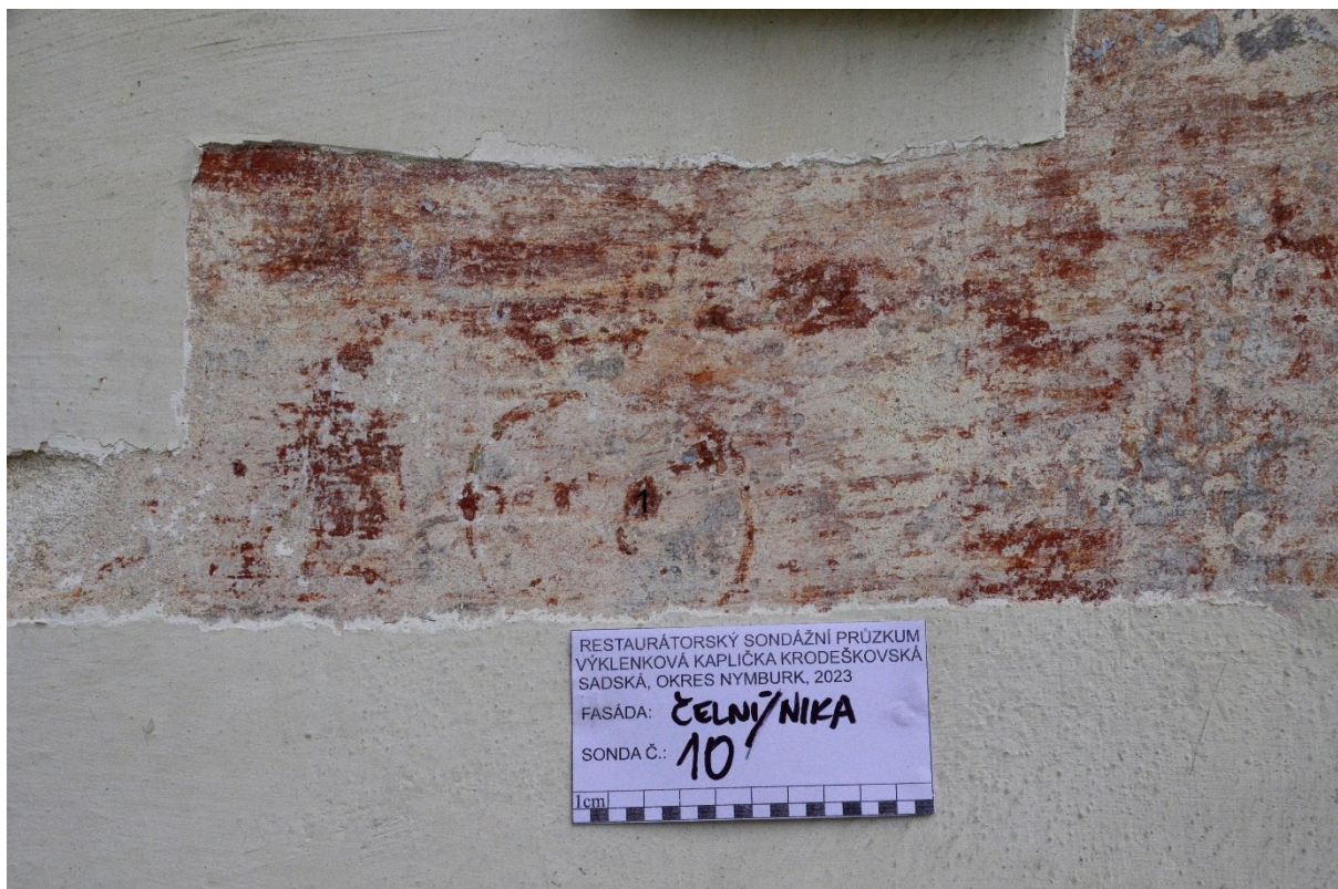
Obr. 17 Detail sondy č. 10, původní barevná vrstva červená (1), dle kruhového tvaru ve spodní části sondy je pravděpodobná přítomnost blíže neurčeného malovaného členění.
