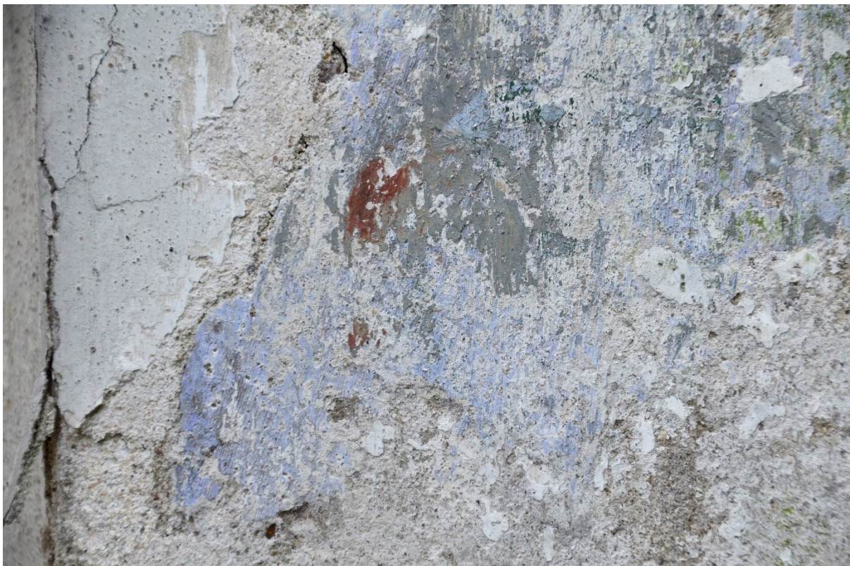
Obr. 20 Detail barevných vrstev v sondě č. 11, vlevo vysprávka. V nižších partiích je stav dochování barevných vrstev horší.
