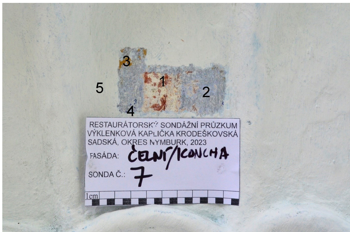
Obr. 13 Sonda č. 7 v nice. Stratigrafie: 1 – červená (fragmenty), 2 – šedomodrá, 3 – tmavý žlutý okr (fragmenty), 4 – tmavě modrá (fragmenty), 5 – bílá současná
