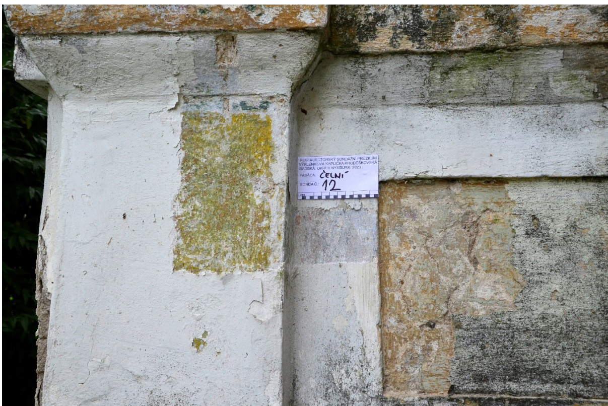
Obr. 21 Sonda č. 12, sic v mnohem horším stavu, ale vrstva malby je přítomna (zde tmavě zelená linie v horní části sondy).
