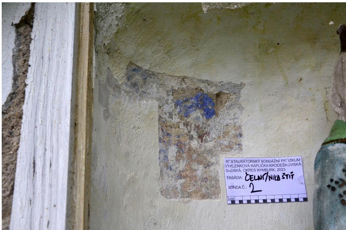
Obr. 4 Sonda č. 2 v nice štítu, zda byla nika původně červená nebo modrá je ještě třeba prověřit rozšířenou sondáží.
