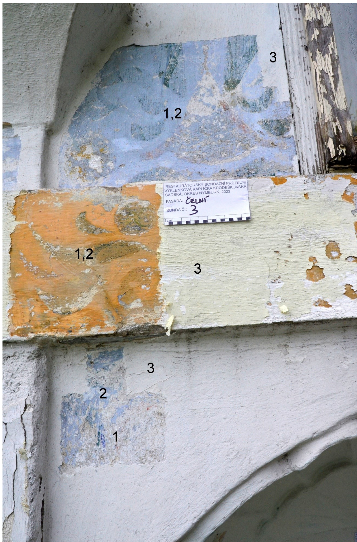
Obr. 6 Stratigrafie obdobná jako v případě S1, na vrstvě dekorativní malby (1) se nachází špatně odstranitelná světle modrá/okrová (2) vrstva a dále mladší, převážně bílá současná (3).
