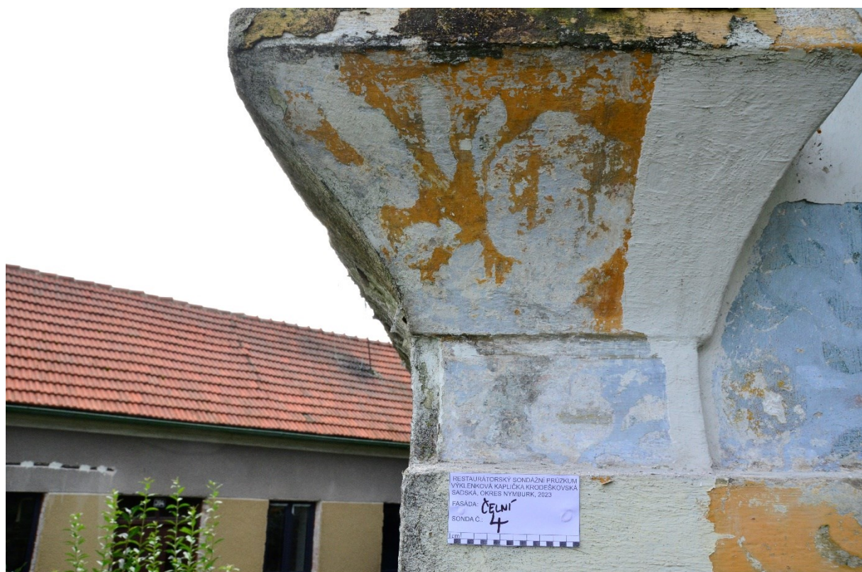
Obr. 8 Sonda č. 4, na hlavici je patrné stejné schéma dekorativních rozvilin jako v ploše. Původní barevné vrstvy značně poškozené, čitelnost rozvilin je dána přítomností okrové následné vrstvy v místech kolem listů a květu.
