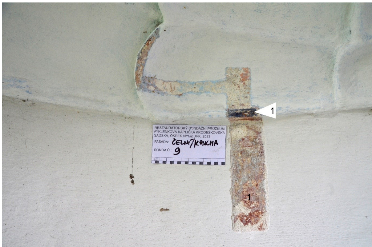
Obr. 15 Sonda č. 9 v nice, původní barevná vrstva v mušli i pod ní červená, okraj černě odlišený (1).
