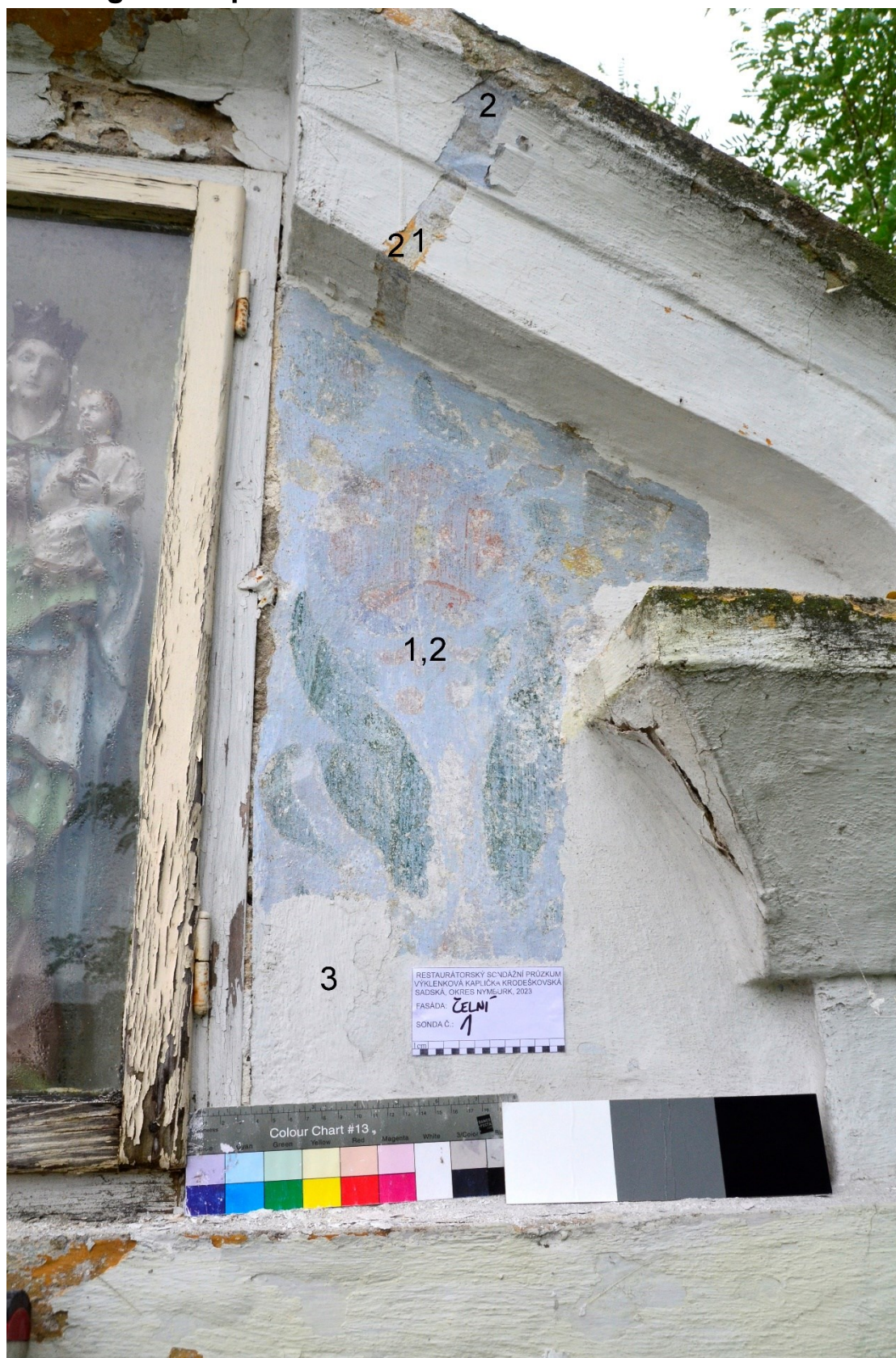
Obr.1 Sonda č. 1 vedle zasklené niky štítu prokazatelně listy a květ v nejstarší vrstvě (1), přetřeno světle modrou (2), velmi špatně odstranitelnou, na části římsy je v pozici druhé vrstvy sytá žlutě okrová, následuje bílá současná (3), vrstvy v minulosti odstraňovány.
