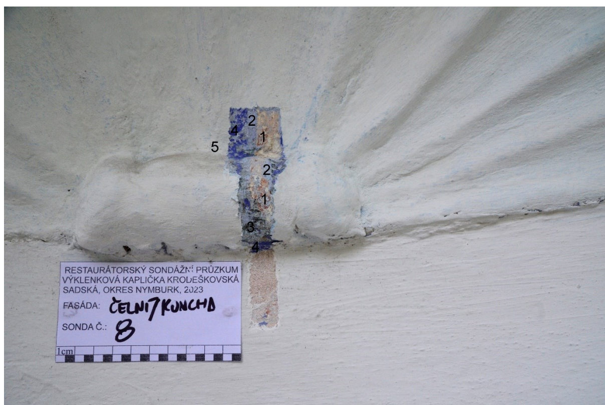
Obr. 14 Sonda č. 8 v nice. Stratigrafie: 1 – červená (fragmenty), 2 – šedomodrá, 3 – černá (fragmenty), 4 – tmavě modrá, 5 – bílá současná.
