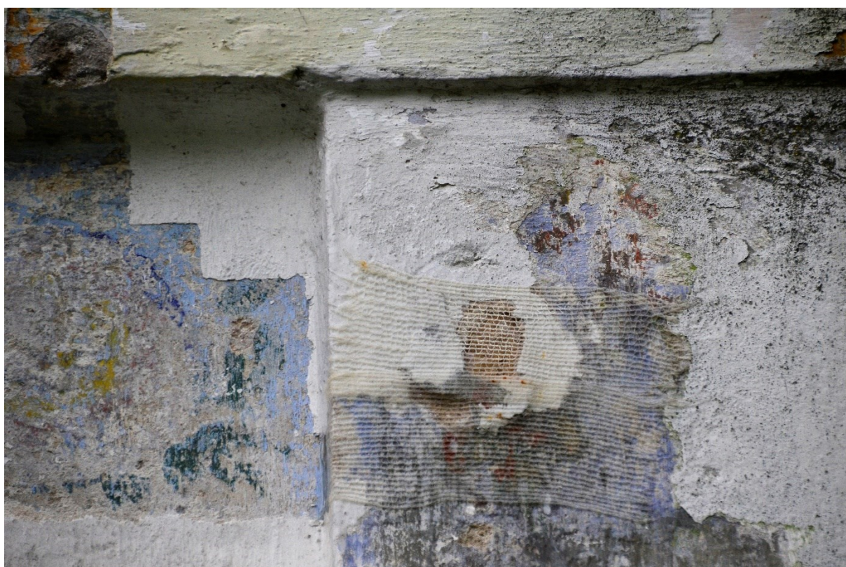
Obr. 18 V horní části pravého pilastru byl přelepem zajištěn uvolněný fragment omítky s původní barevnou vrstvou (gáza, Tylosa MH 1000).
