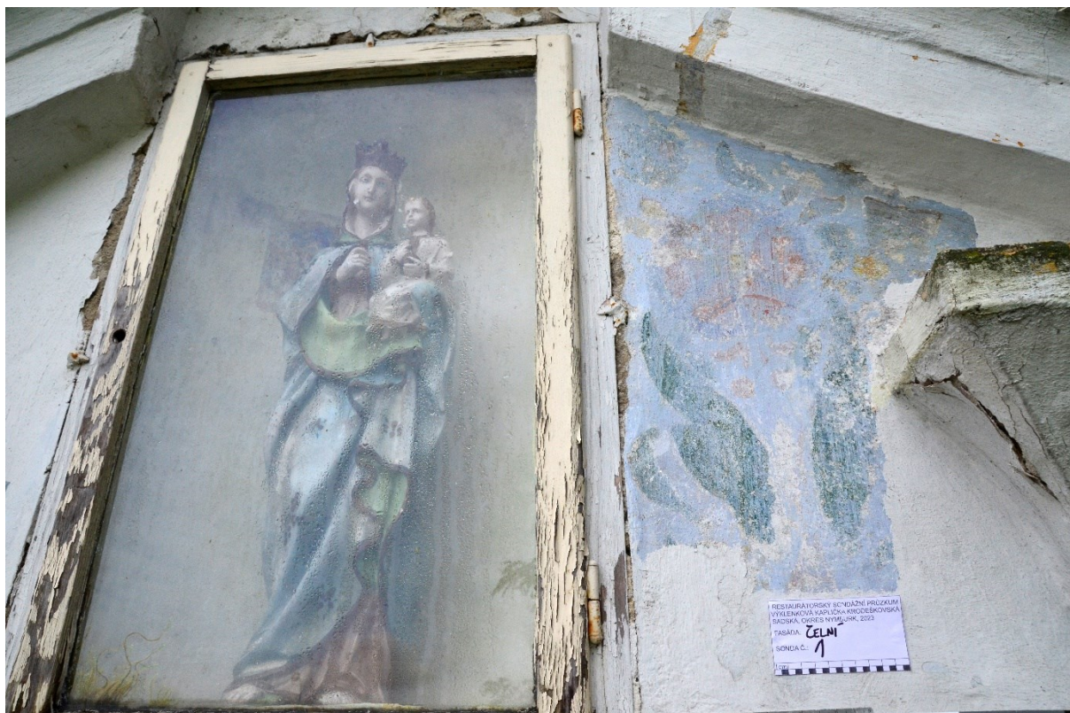
Obr. 2 Nika štítu s novodobou sádrovou soškou Panny Marie a sonda č.1.
