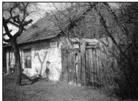
Domek čp. 30/II ve Vagonové čtvrti
