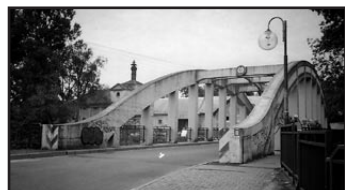
Most přes Divokou Orlici v Borohrádku
