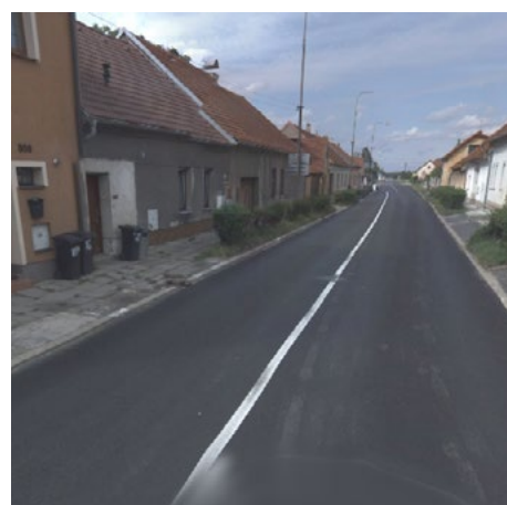
OPRAVA 40 LET NEUDRŽOVANÉHO CHODNÍKU
