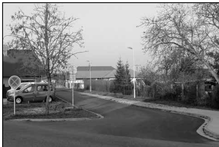
Úpravou letos prošlo vyústění ulice Karla Víky do Lázeňské. Součástí investiční akce byla také instalace veřejného osvětlení v této ulici. Foto Petr Kopecký
