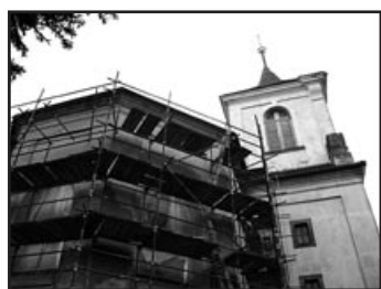
V červenci započala oprava fasády severní strany kostela sv. Apolináře.
