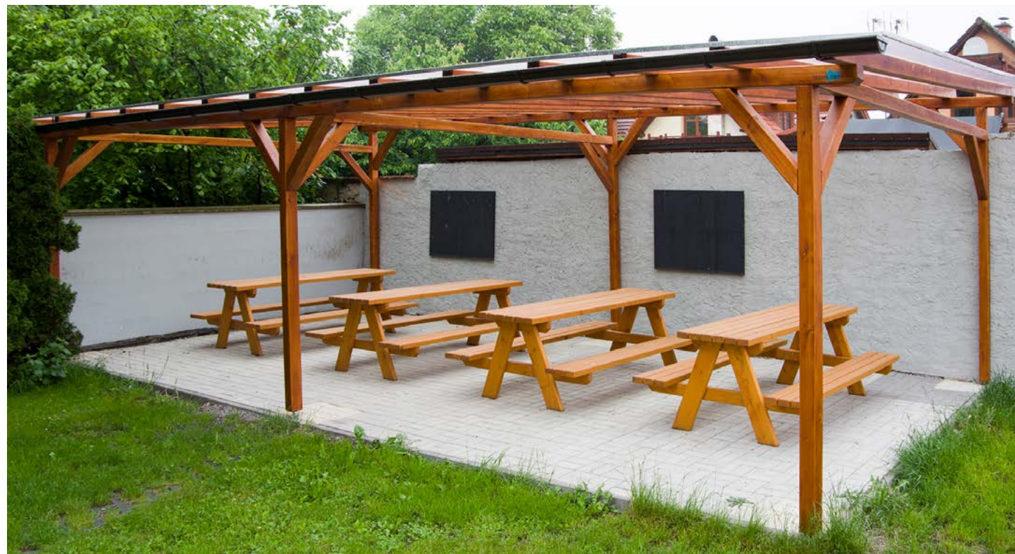
V zahradě mateřské školky byl nově zbudován přístřešek, který bude sloužit jako venkovní učebna.
