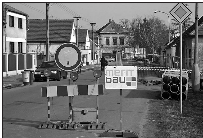
Uzavírkou silnice začala stavba nové kanalizace v Pražské ulici. Podle předpokladu potrvá do konce dubna.
